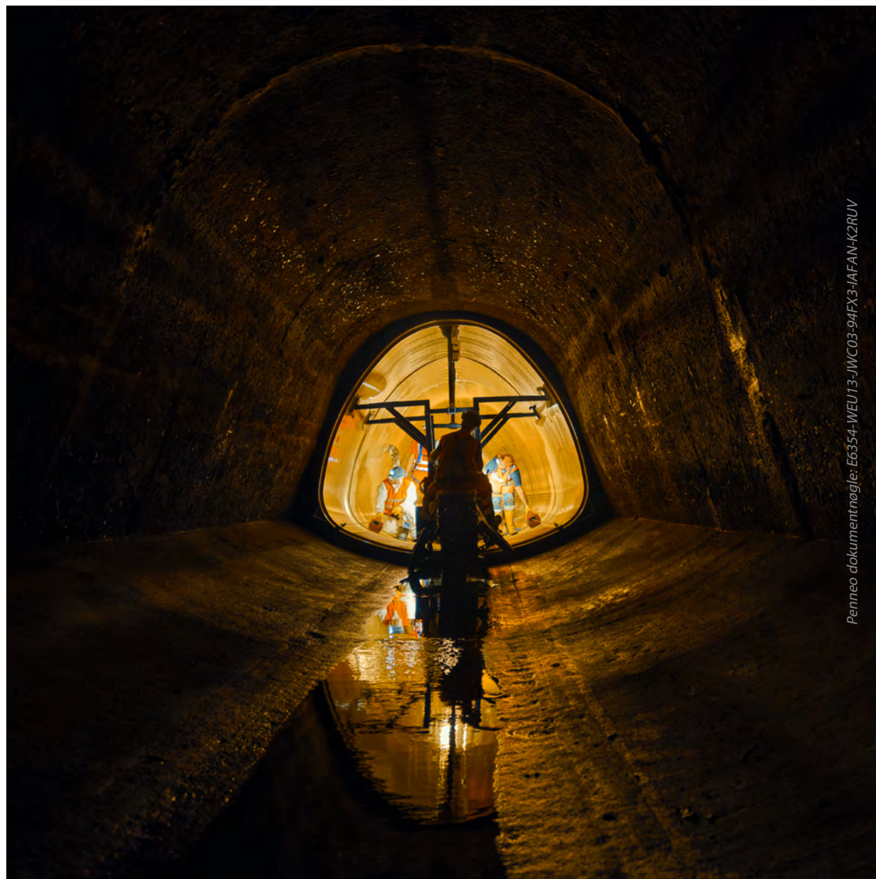
Belvedere-kloakledningen under Hovedbanegården, København
