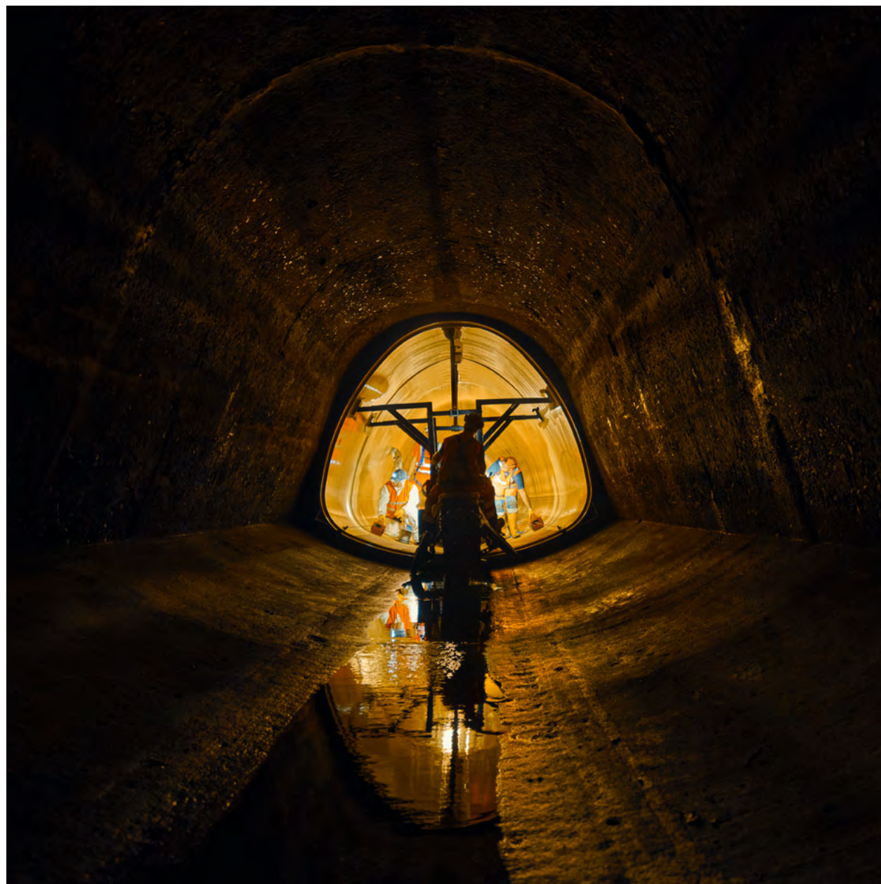
Belvedere-kloakledningen under Hovedbanegården, København
