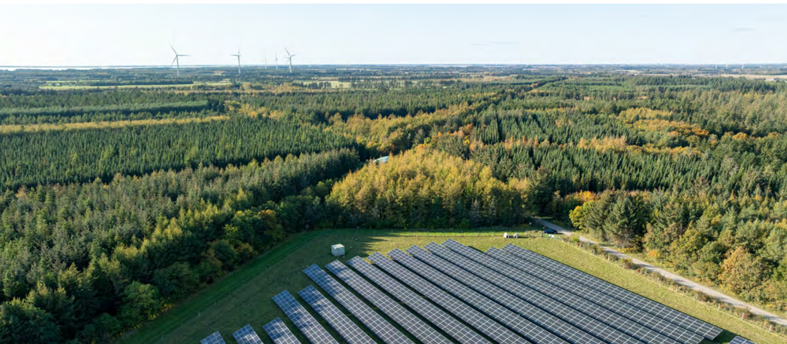
Solceller ved Nees og Kikkenborg
