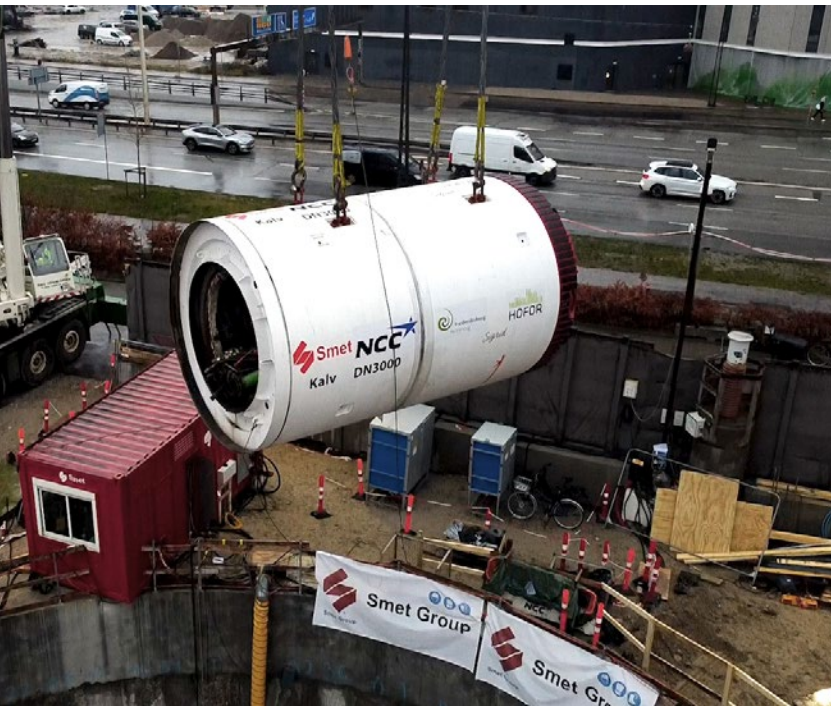
Ankomst af tunnelboremaskinen til Kalvebod Brygge Skybrudstunnel
