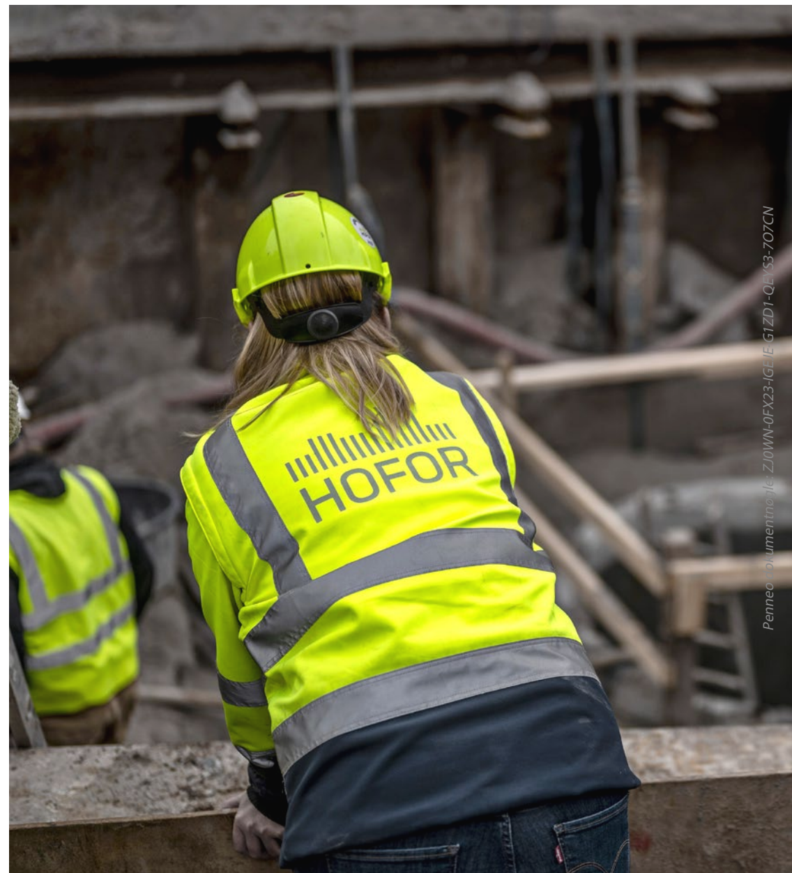
Anlægsarbejde af Strandboulevarden Skybrudstunnel på Østerbro i København
