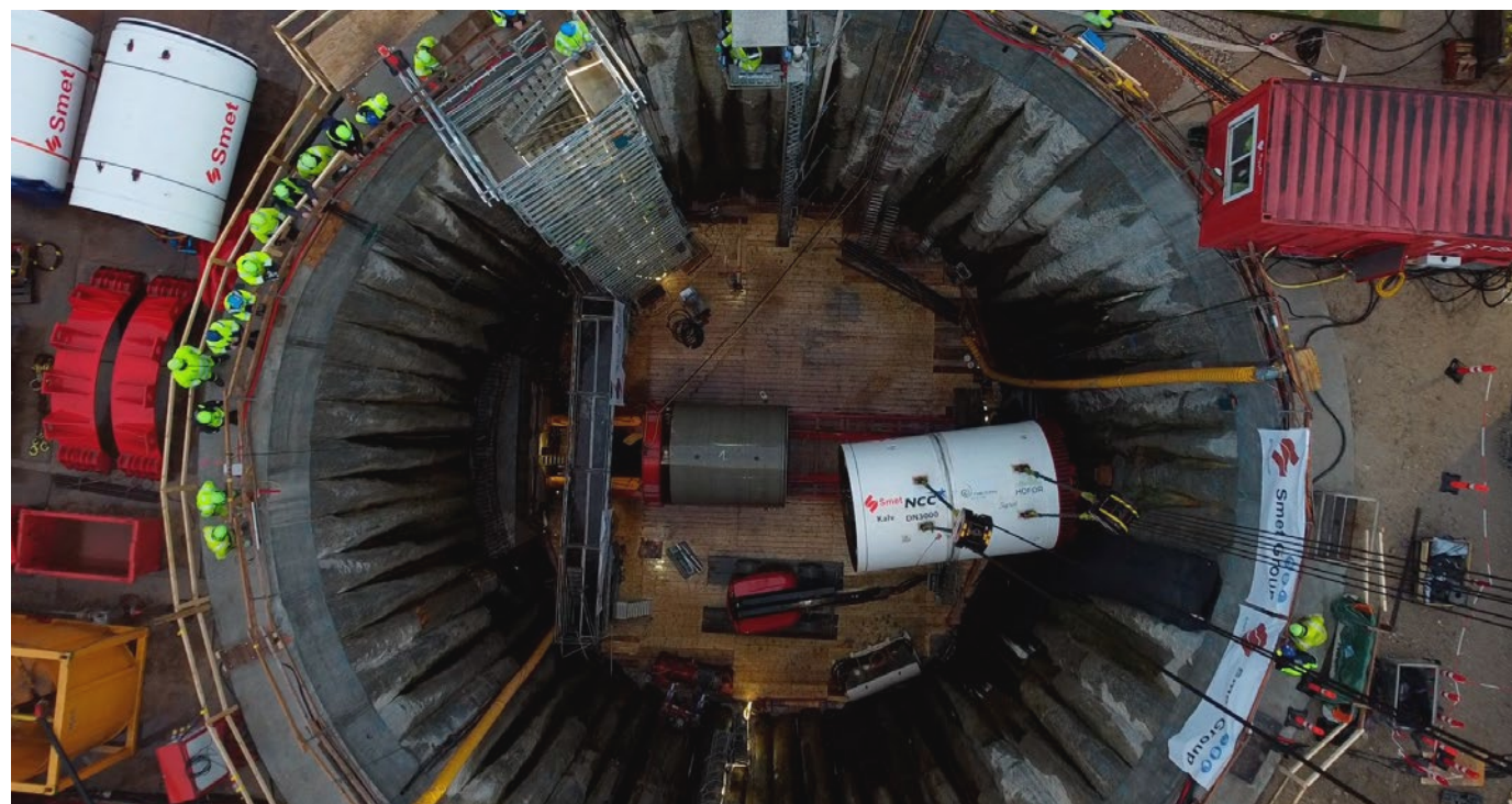
Tunnelboremaskinen døbes Sigrid, klar til næste etape af Kalvebod Skybrudstunnel
