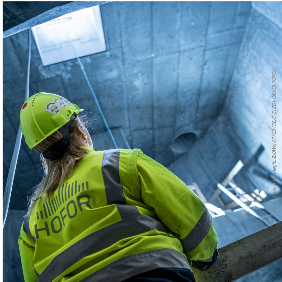
Kig op fra bunden af skybrudstunnel
