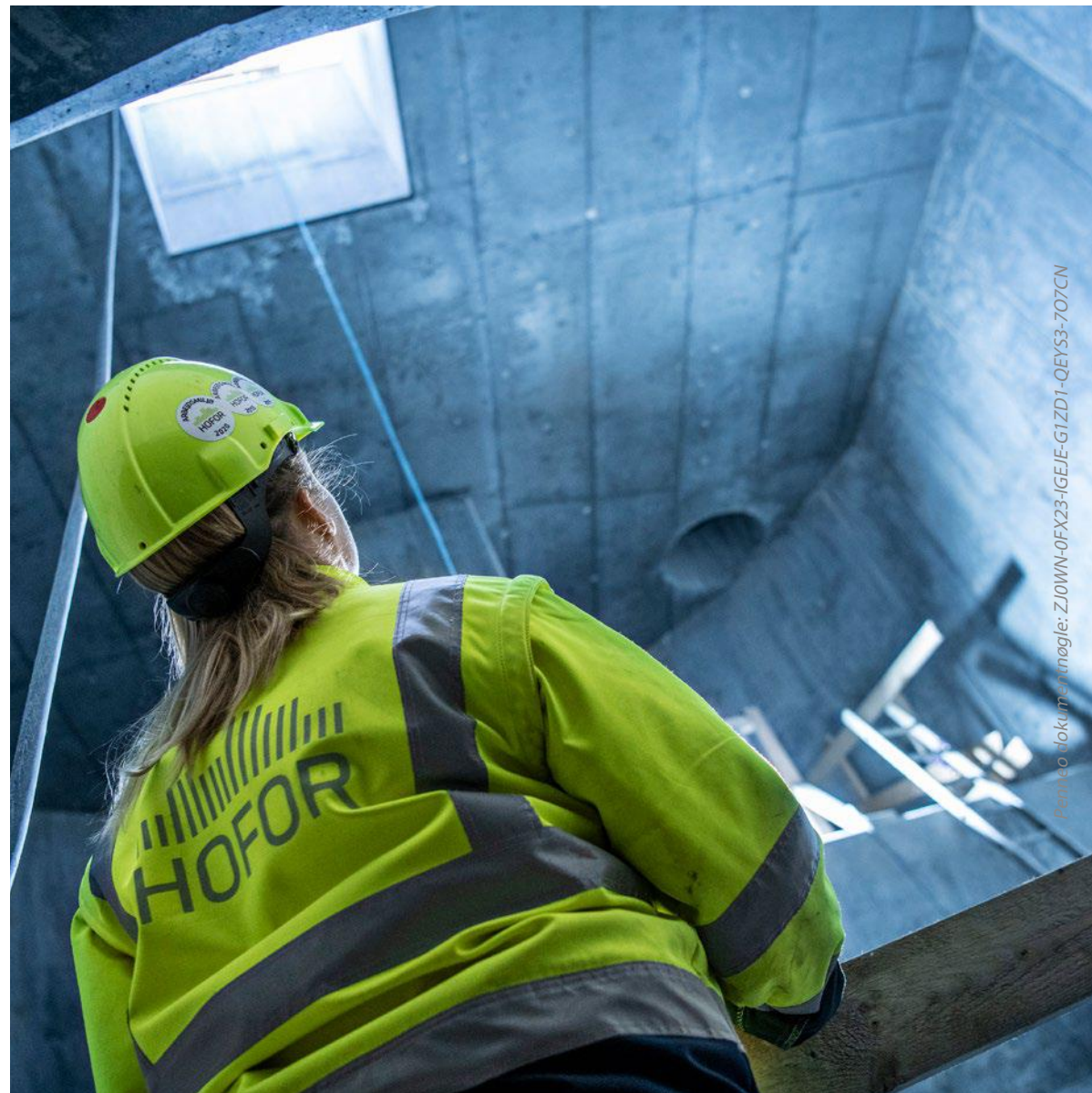
Kig op fra bunden af skybrudstunnel
