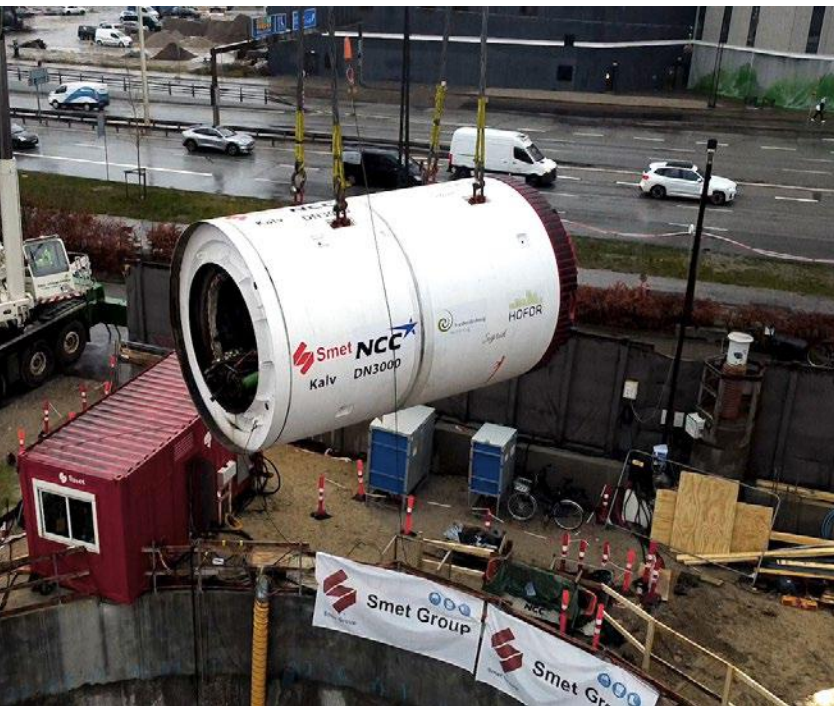
Ankomst af tunnelboremaskinen til Kalvebod Brygge Skybrudstunnel
