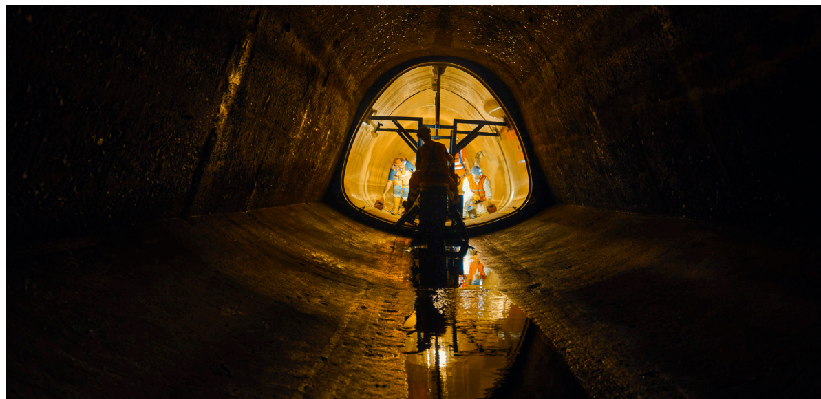
Belvedere ledningen under Københavns Hovedbanegård
