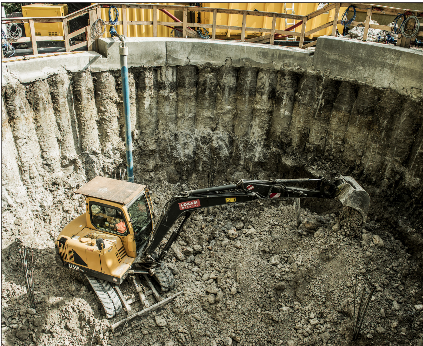
Skakt udført med sekantpæle.
