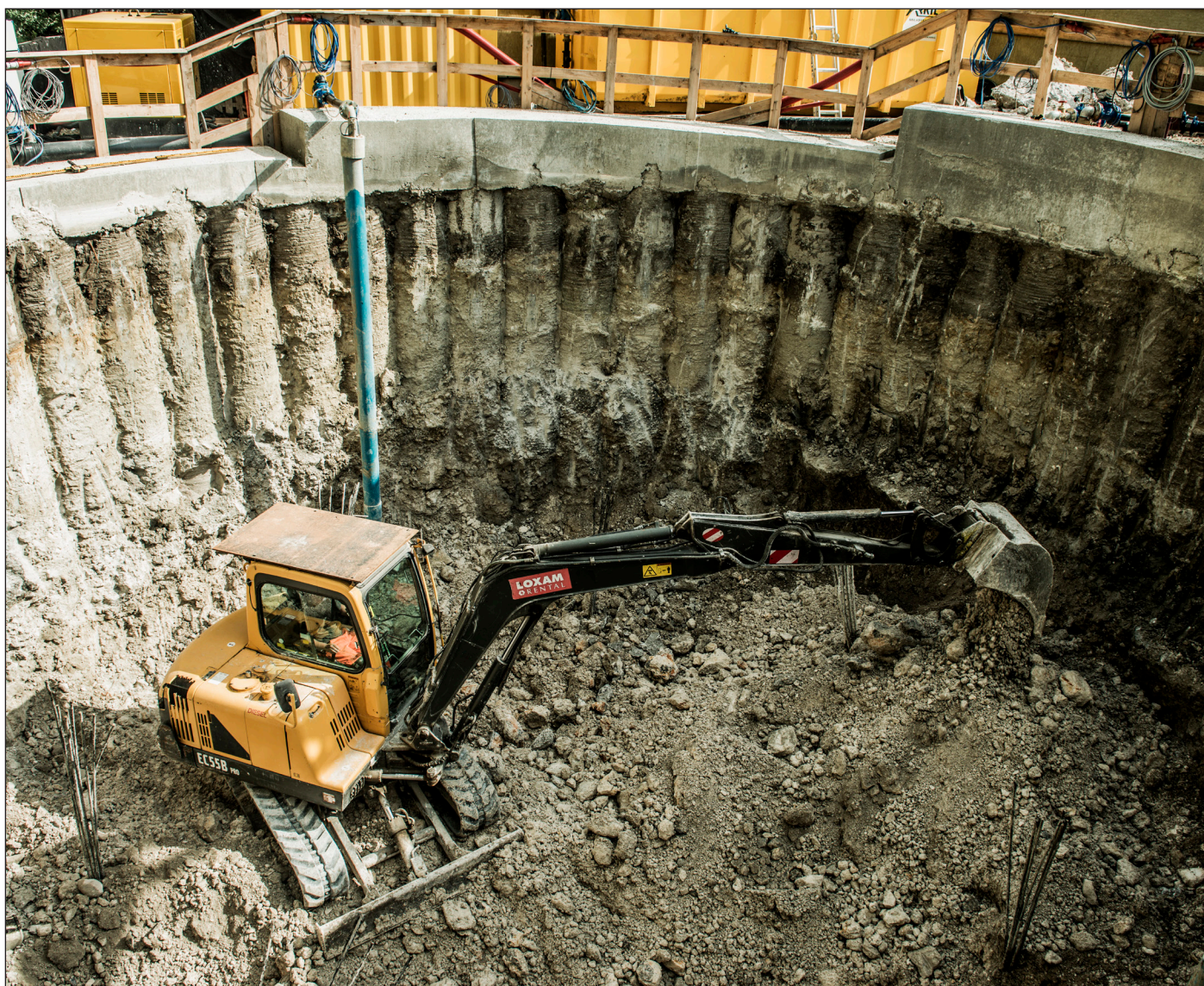
Skakt udført med sekantpæle.
