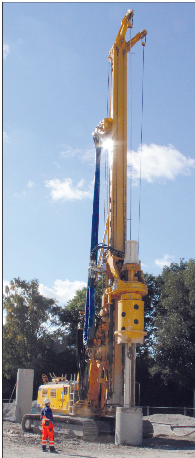
SEKANTPÆLE. Sekantpæle etableres med en stor boremaskine, som borer et dybt hul i jorden, der herefter fyldes med beton. Etablering af vægge til skakte er almindeligvis den mest støjende aktivitet i anlægsperioden.
